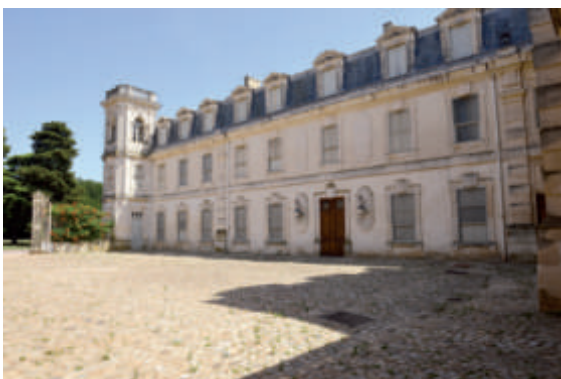
Façade nord du château.
