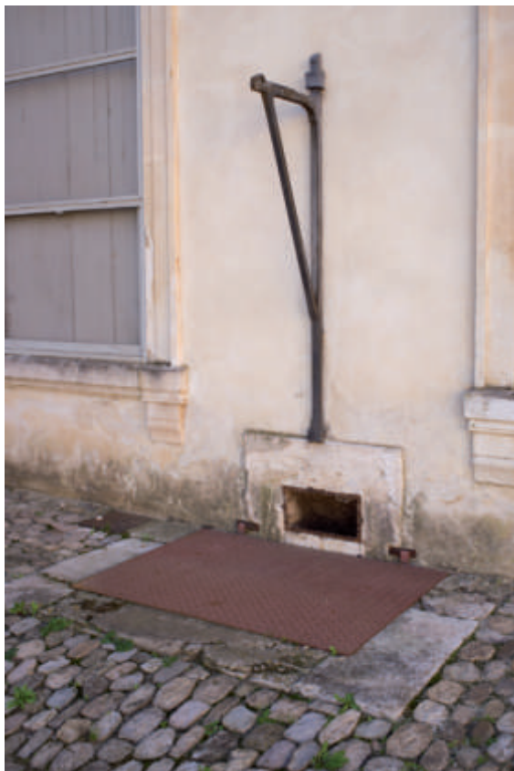
Monte-charge, entre la cave et la cour, côté cuisine.
